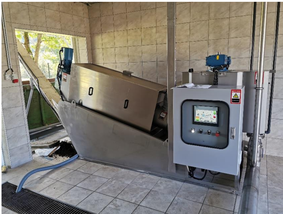
Slika 4: Nova počasi rotirajoča dehidracijska naprava
