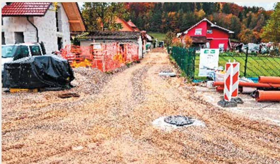
V Koloniji je že nekaj tednov asfalt
